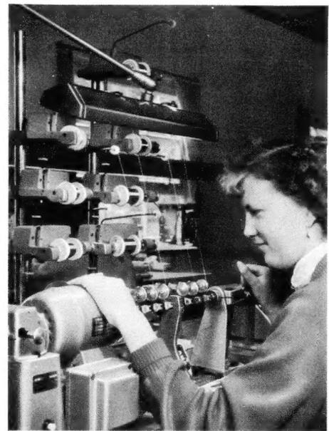
Sechs Miniaturübertrager entstehen gleichzeitig an dieser Feindraht-Wickelmaschine
